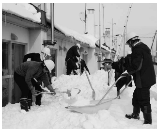
日差しを遮る窓側を除雪
