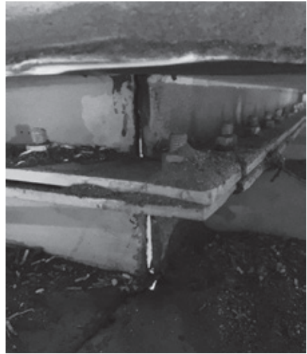
A系焼却炉・ごみシュート修繕
