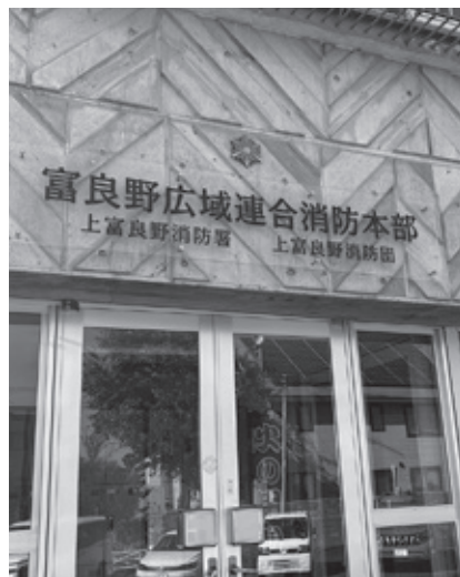
富良野市へ移転される消防本部
