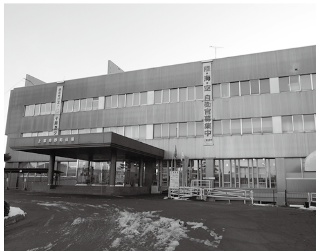
早期改修が望まれる庁舎
