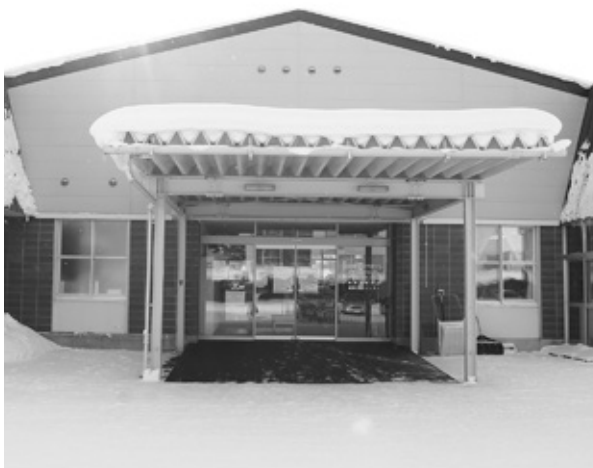
町立病院の改築により取壊しが検討されている子どもセンター
