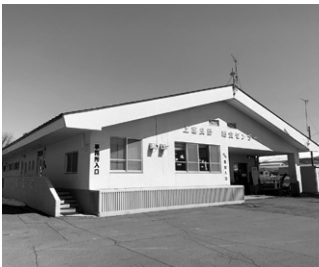
老朽化が進む給食センター
