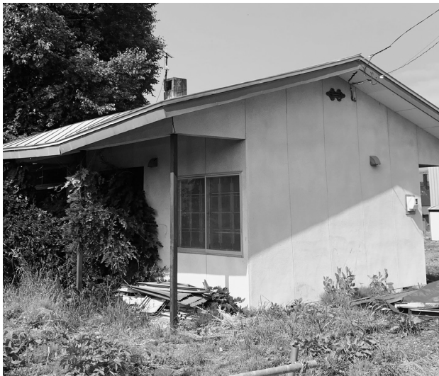
長年放置されている空き家
