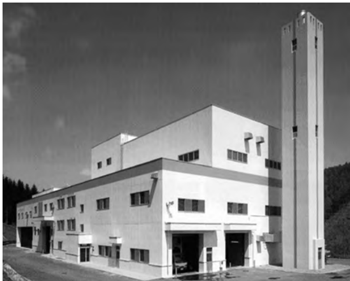
建設から 19 年が経過したクリーンセンター
