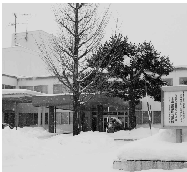
老朽化し改築が必要な町立病院
