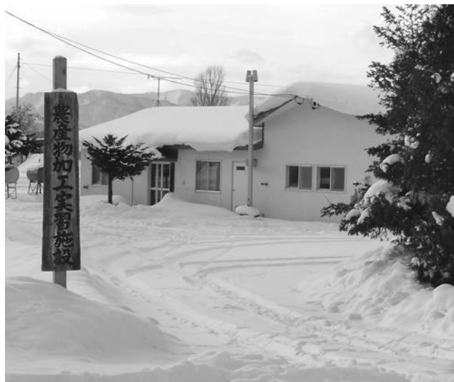
老朽化している農産物加工実習施設
