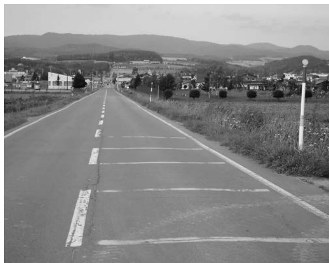
歩道のない町道北 27 号道路
