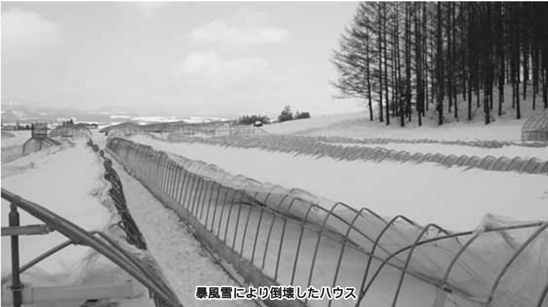
暴風雪により倒壊したハウス
