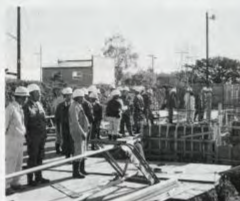
西小改築工事現場を調査
