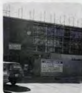
町武道館建設工事
