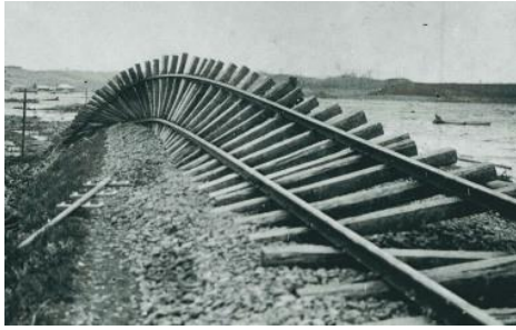
【写真①】捻じ曲げられた線路
