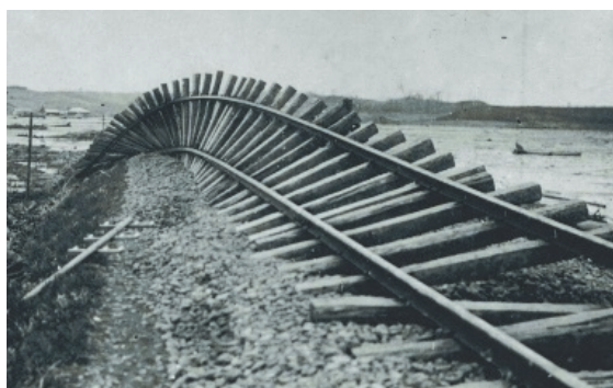
【写真②】 捻じ曲げられた線路(草分地区)
