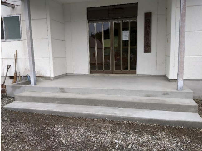
日新分館玄関ポーチ階段改修工事
