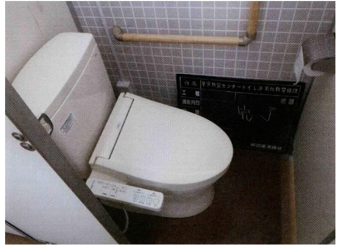
草分分館トイレ改修工事
