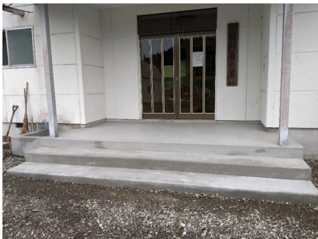
日新分館玄関ポーチ階段改修工事
