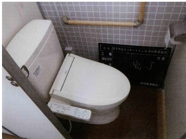
草分分館トイレ改修工事
