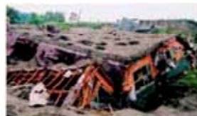
有珠山の噴火で噴石の直撃により屋根に穴が開いた建物
