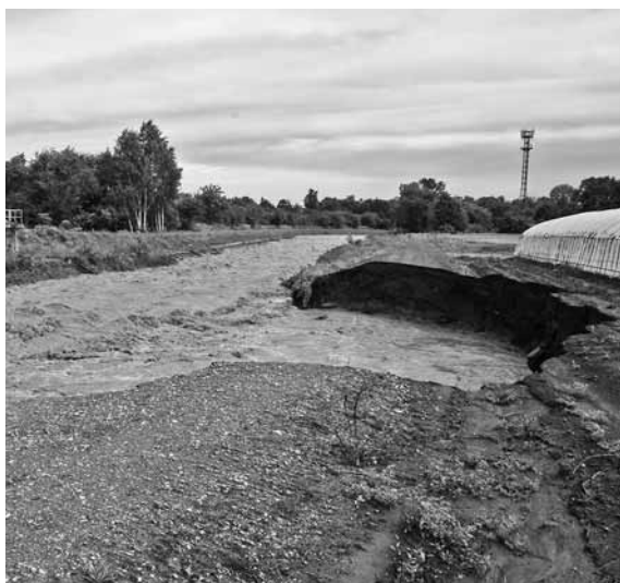
大きくえぐられた堤防(ヌッカクシ富良野川)
