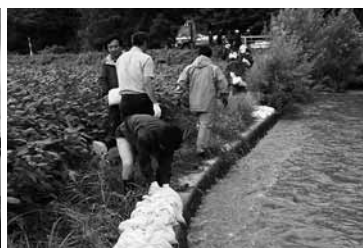
氾濫防止の土のう積み
