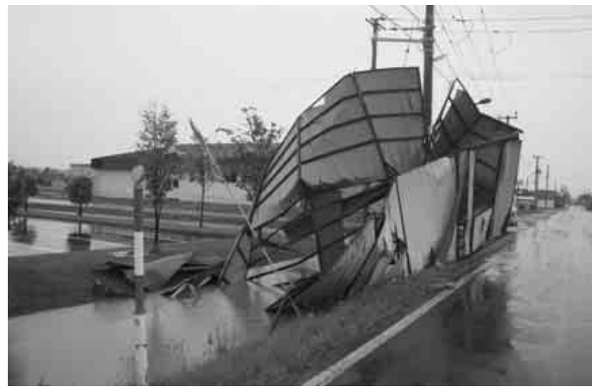
突風で飛ばされた車庫(基線北27号)
