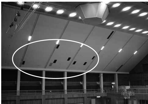
応急処置として落下の危険があるロックウールボードを撤去
