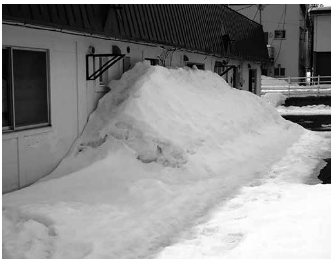
扇町町営住宅の空き室
