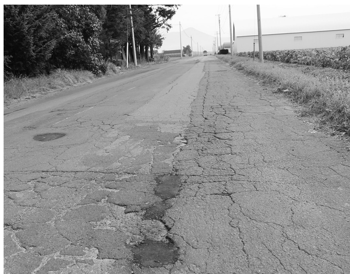
一部未整備の翁道路
