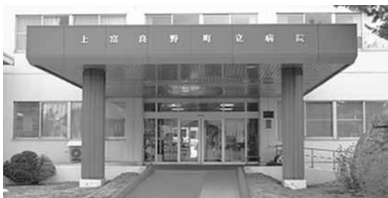
整備が望まれる町立病院
