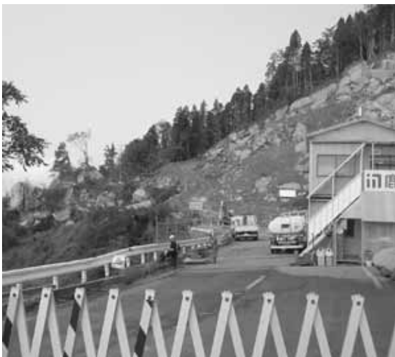
新潟県中越地震による崩落現場
