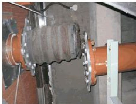
汚泥管の損傷(処理場) (平成19年 新潟県中越沖地震)
