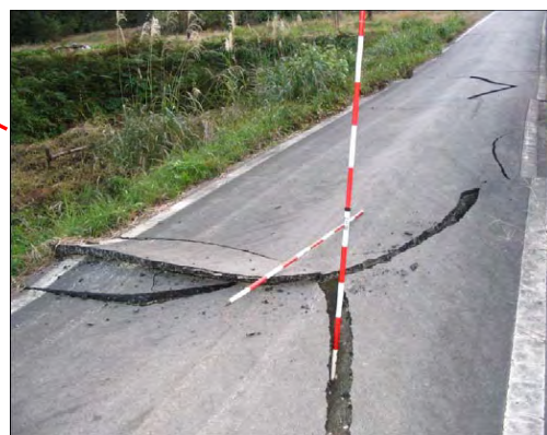
舗装道路のひび
