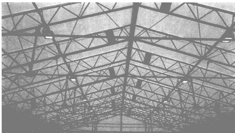
賑わいテント照明設備
