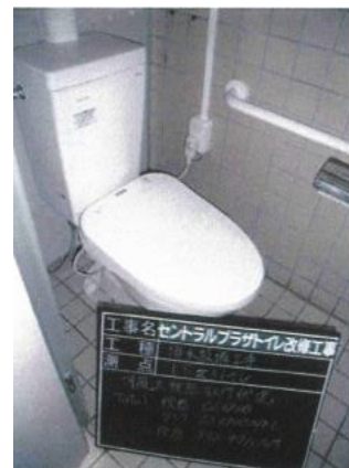
セントラルプラザトイレ改修
